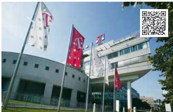
Mehr als 8000 HANSA RLT-Anlagen mit mechanischer Kühlleistung zwischen 7 und 125 kW und Volumenströmen von mindestens 1 500 m 3 /h wurden für die Deutsche Telekom gebaut und installiert.
