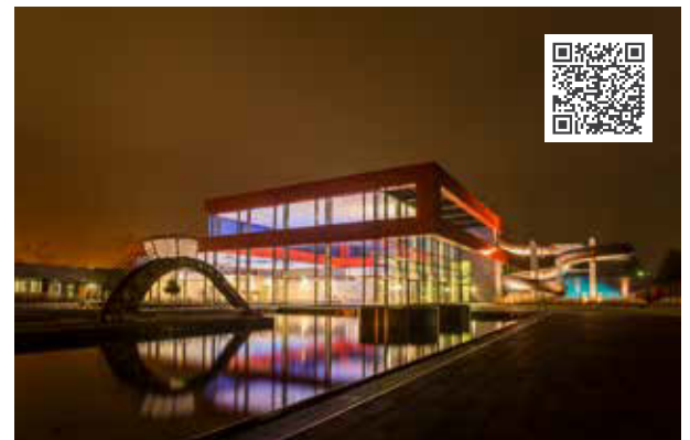
Vollständige Ausrüstung mit HANSA-Klimatechnik (Entfeuchtung mit 50 000 m 3 /h, diverse Lüftungsgeräte für Nebenräume).
