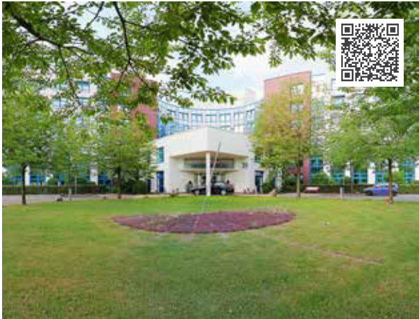
Im Herzzentrum Leipzig sorgen mehrere Blue Line Hy für eine gesundheits- und normgerechte Belüftung u.a. der Stationen.
