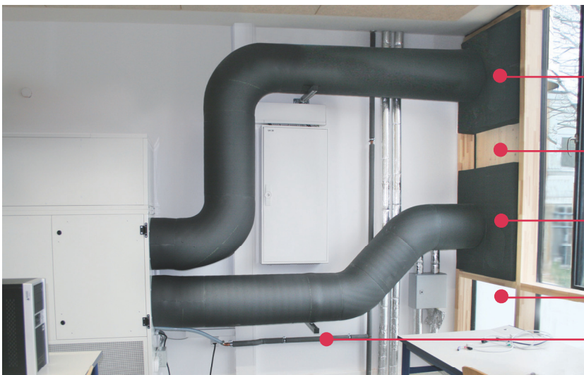
Abbildung: Verrohrung der SupraBox DELUXE 750 H
