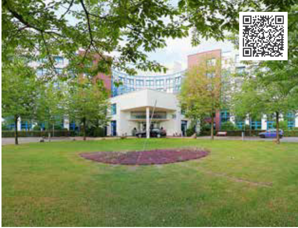
Im Herzzentrum Leipzig sorgen mehrere Blue Line Hy für eine gesundheits- und normgerechte Belüftung u.a. der Stationen.
