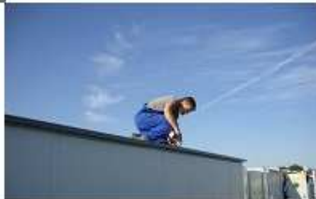
Montageunterstützung / Montage vor Ort
