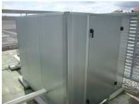
Schalldämmung Dachaufbau
